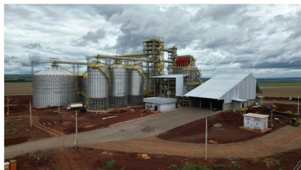
Armazéns de grãos na unidade de recebimento da Coama em Itahum, na região de Sidrolândia
